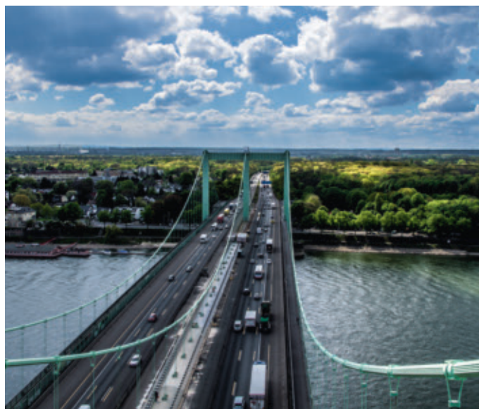
Der Neubau der Brücken Leverkusen und Rodenkirchen ist dringlich
