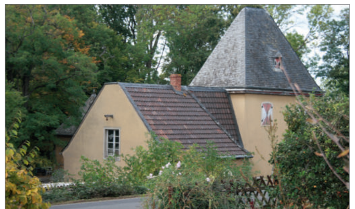
Ein Geschichtswanderweg soll in Niederberg entstehen. Auch die alte Wasserburg gehört dazu.
