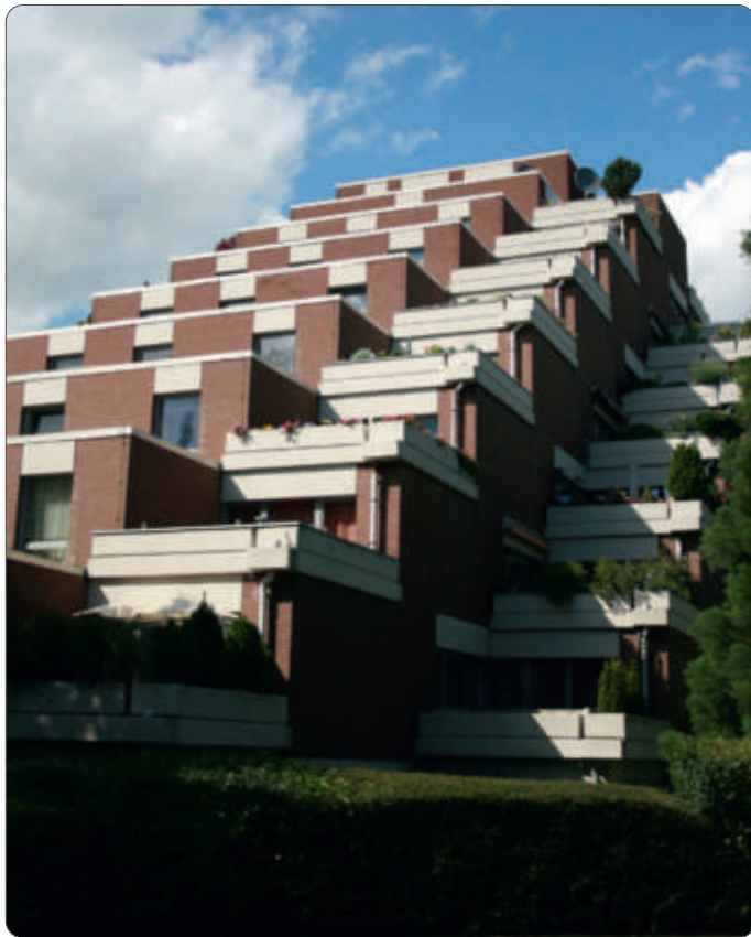
Modern: Das Hügelhaus in Liblar ist ein Beispiel für den Bauboom und die Kreativität der frühen Jahre.
